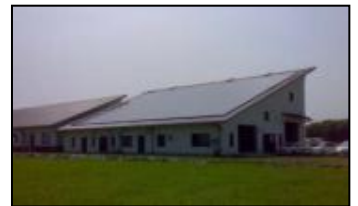
太陽光発電施設
