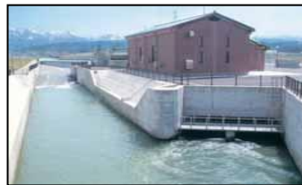
小水力発電施設
