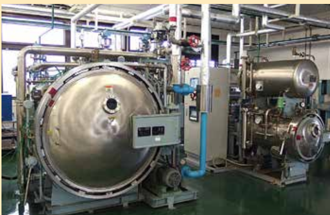
プラント室内 (加熱殺菌装置)
