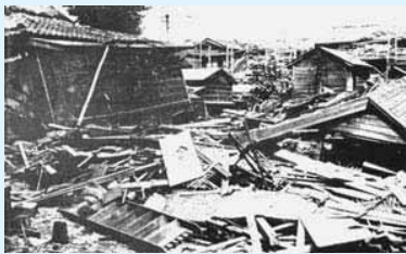
関東大震災・深川倒壊家屋
